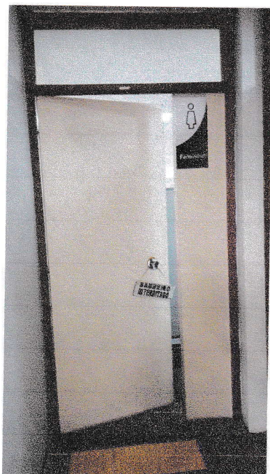
17° andar banheiro feminino interditado- 15/08/2024
